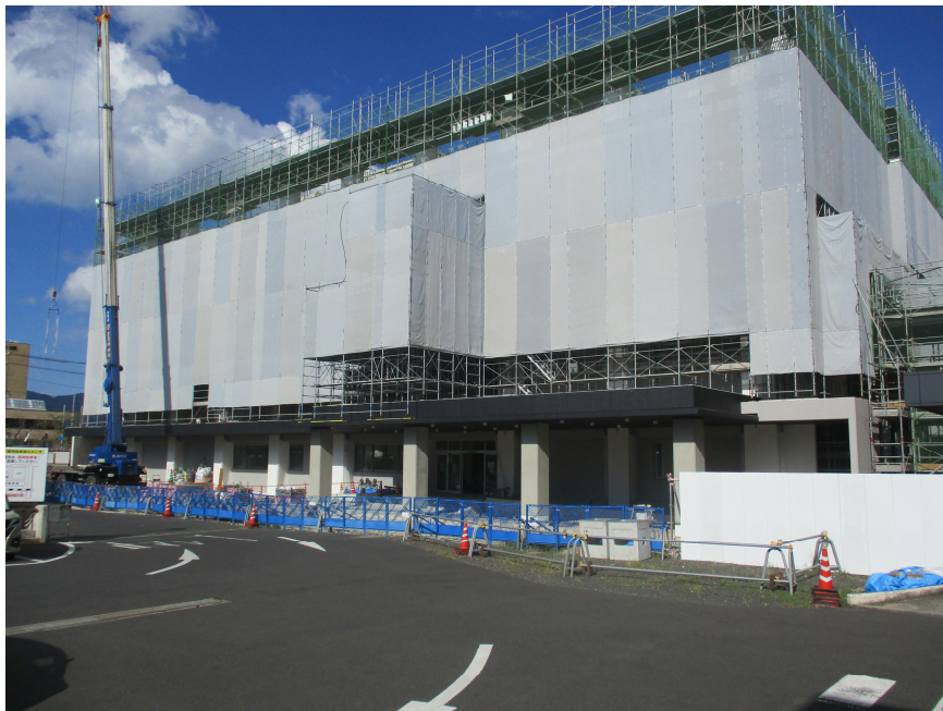
工事進捗状況（令和6年9月10日現在）
