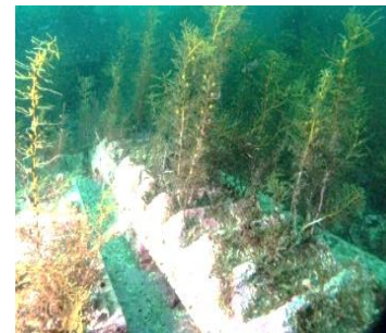
ハード対策(藻場礁設置)
