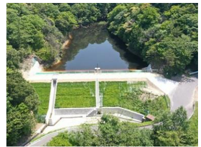
整備済みのため池
