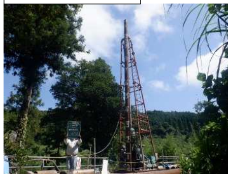
抑止工（杭工）
