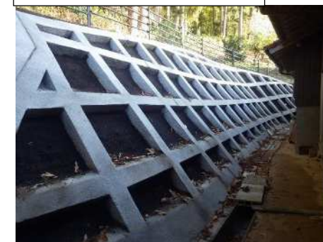
斜面改良工（法枠工）
