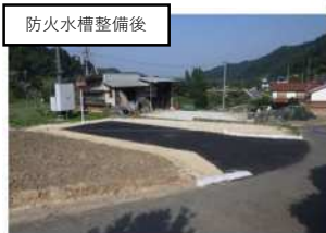
防火水槽整備後
