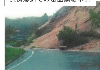
近傍農道での法面崩壊事例
