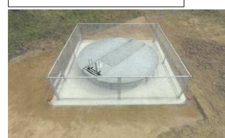
地下水排除工（集水井）
