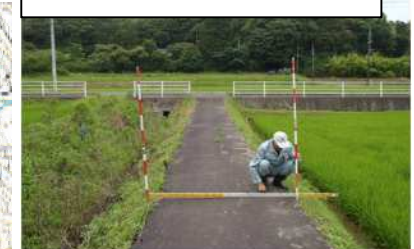
狭幅な道路（全幅2.0m）
