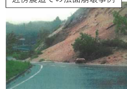
近傍農道での法面崩壊事例
