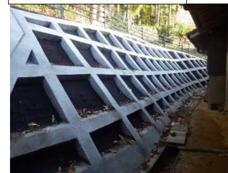
斜面改良工（法枠工）
