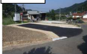
防火水槽整備後
