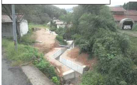
地表水排除工（排水路）
