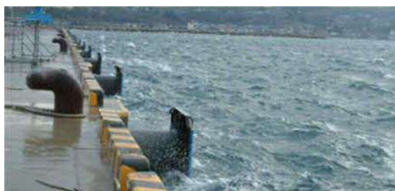
写真－3 海上が荒れた際は岸壁利用が困難
