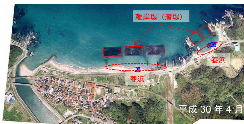
写真－10 (三隅港海岸) 侵食対策
