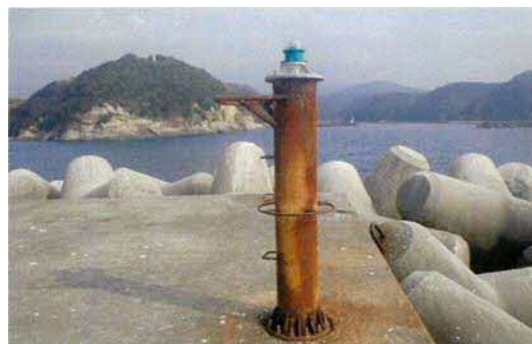
写真－１６ 小規模な施設修繕
