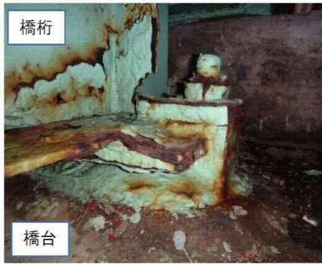
〔支承〕 平成 26 年点検
