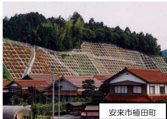
写真－４ 斜面对策工（法枠工）
