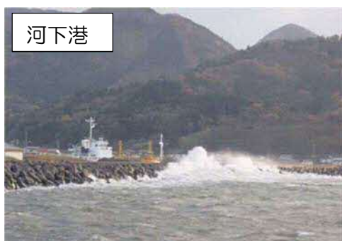
写真-5 海上が荒れた際の岸壁状況
