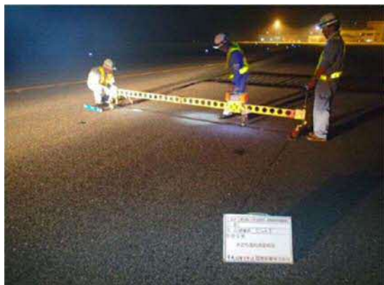
写真-4 滑走路定期点検状況
