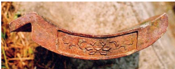
写真8 門脇家住宅米蔵軒棧瓦
