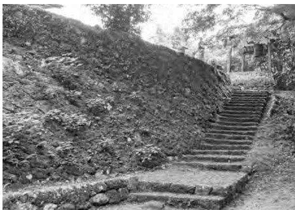
31. 定徳寺参道石段・石垣と鐘撞堂（北西から）
