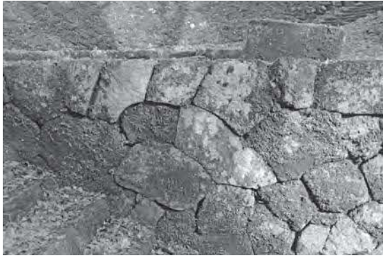
写真1 山門の門前石垣にみる備前石工の技法
