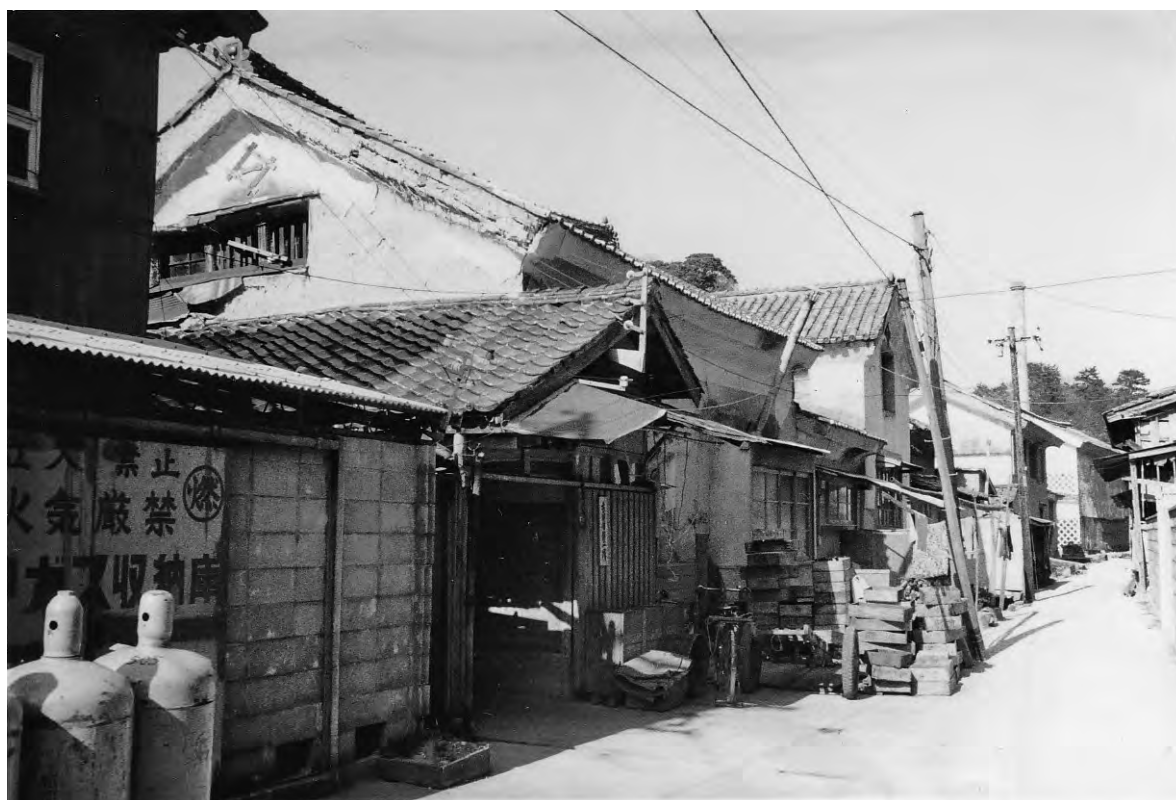
写真1 昭和40年代頃の旧木津屋屋敷 (温泉津川沿い下手から見通す。手前が酒蔵で奥に見えるのが二階建の土蔵。河原秀之氏提供。)
