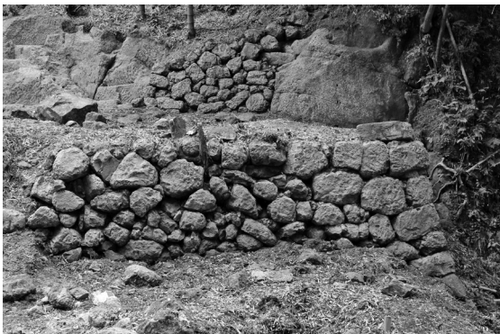
写真3 昆布山谷地区第5地点石垣（Ⅱ類）
