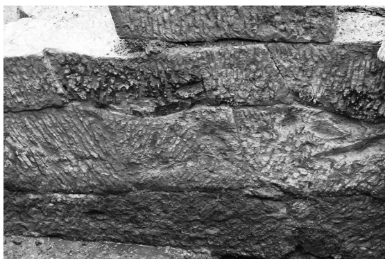
写真6 豊栄神社大溝石垣（曲線加工部分）
