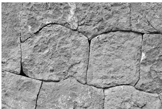
写真5 城上神社本殿石垣（曲線加工部分）
