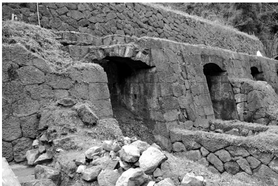
写真16 清水谷製錬所跡アーチ状石垣
