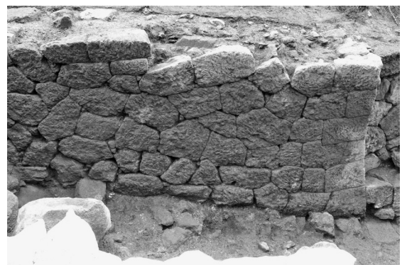
写真9 昆布山谷地区第6地点の石垣
