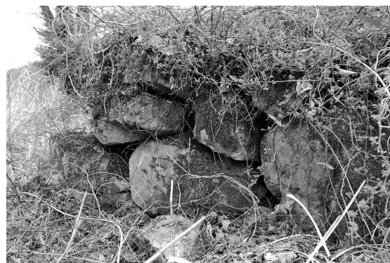
写真1 山吹城跡山頂部石垣
