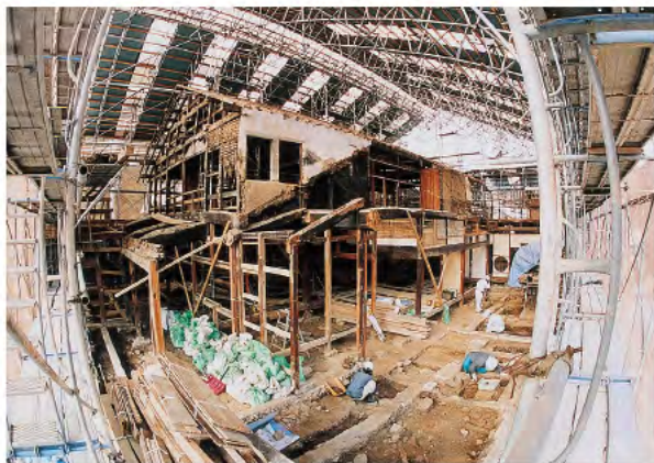
解体修理の様子
