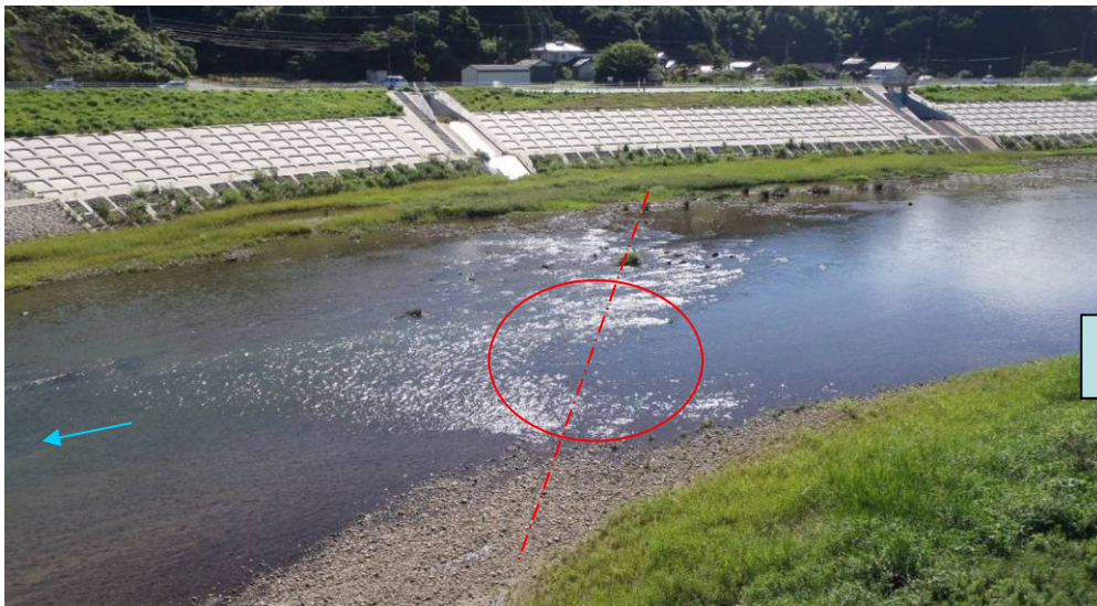
図-7-2 馬木大橋上流写真(調査時)
