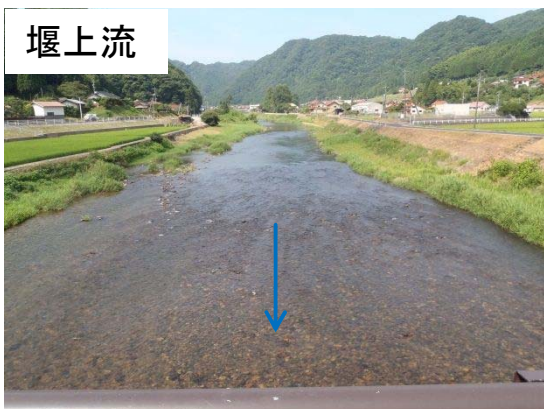
取水施設(八幡原堰)
