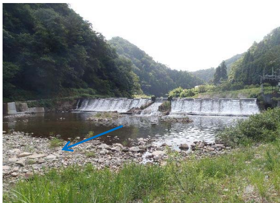
取水施設(窪田堰)
