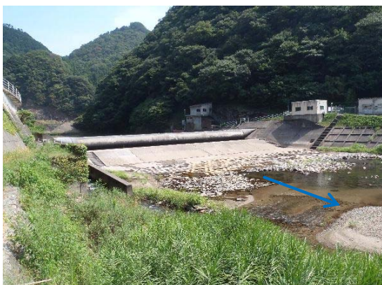
取水施設(八幡原堰)
