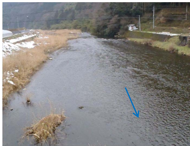
野土橋上流の状況(H24. 2撮影)
