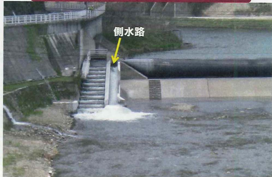
魚道改造工事状況（4月17日撮影）
