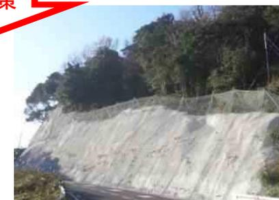
ポケット式落石防護網(100kJ)
