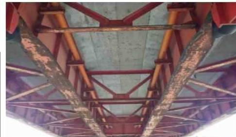
【主桁・横桁の腐食状況】
