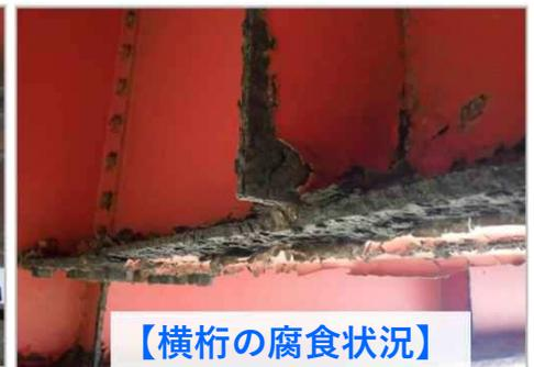
【横桁の腐食状況】
