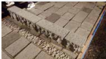
縁石と白線の仕上げの違い
