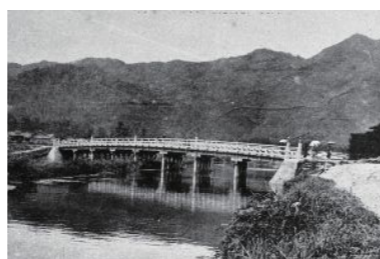
建設直後の宇迦橋
