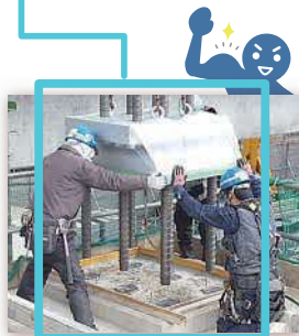
▲上部工を支えるクッションになる部材を設置する様子 (北条高架橋の工事)
