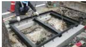
▲ グレーチングを取り付けるための基礎
