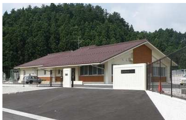
西郷浄化センター（隠岐の島町）
