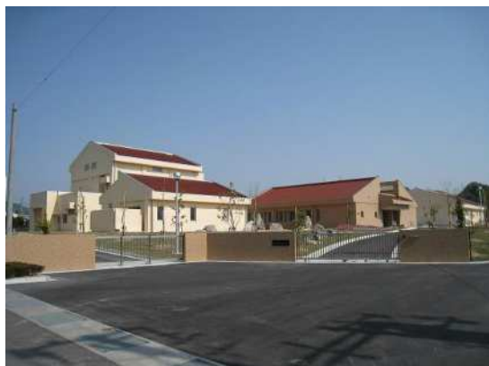
大田浄化センター（大田市）
