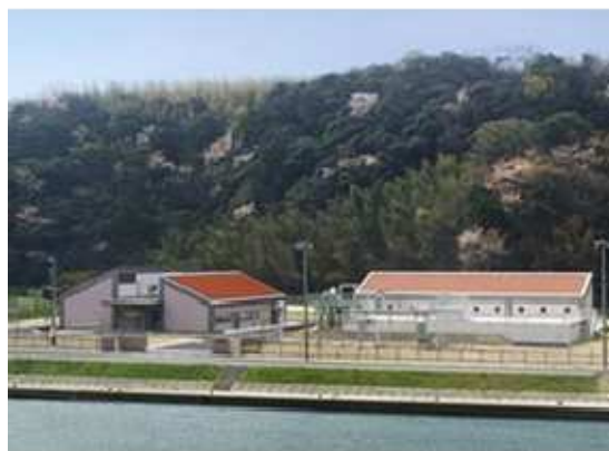
国府浄化センター（浜田市）
