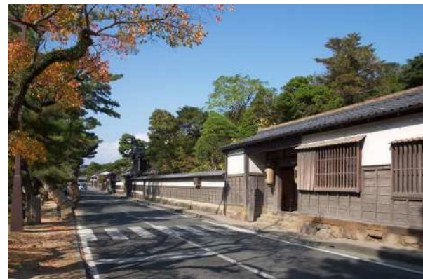
景観地区（松江市）
