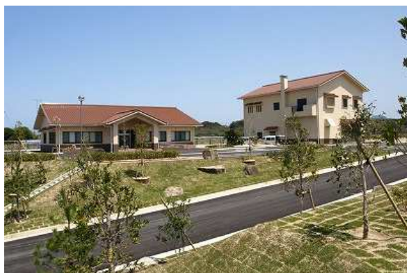
益田水質管理センター（益田市）
