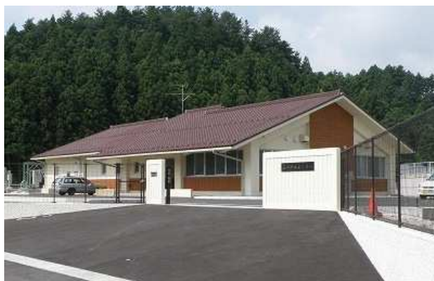
西郷浄化センター（隠岐の島町）
