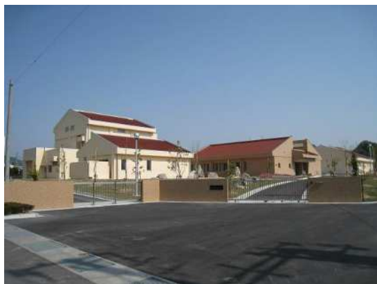
大田浄化センター（大田市）
