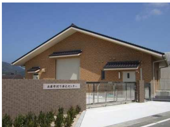
河下浄化センター（出雲市）
