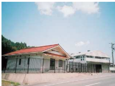
大田市リサイクルセンター（大田市）
