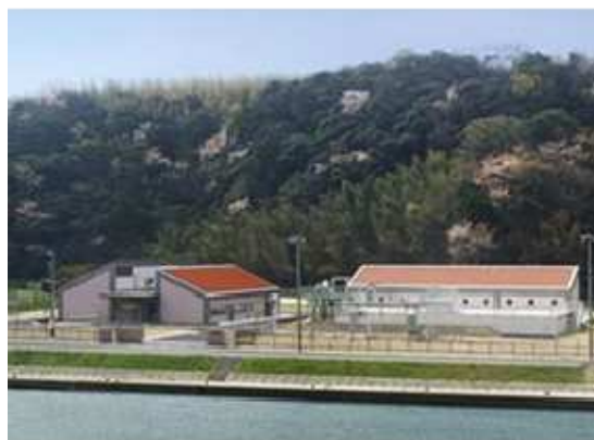
国府浄化センター（浜田市）
