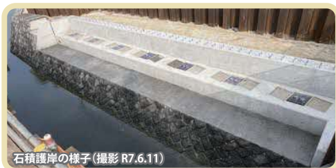
石積護岸の様子 (撮影 R7.6.11)
