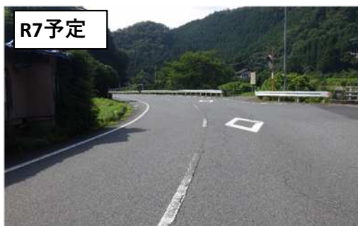
(主) 三瓶山公園線 (野城工区)
