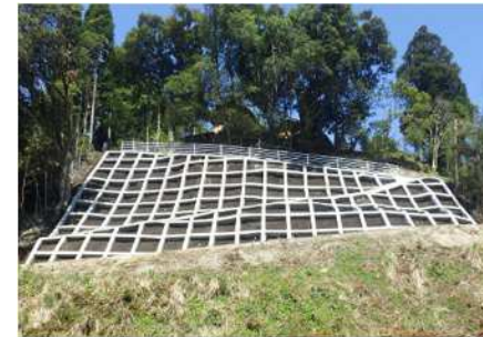
斜面改良工 (不安定土砂の除去、法枠による補強)
