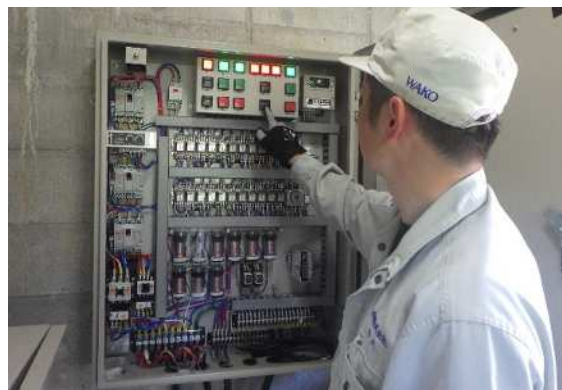
管理設備保守点検 サイレン制御盤点検
