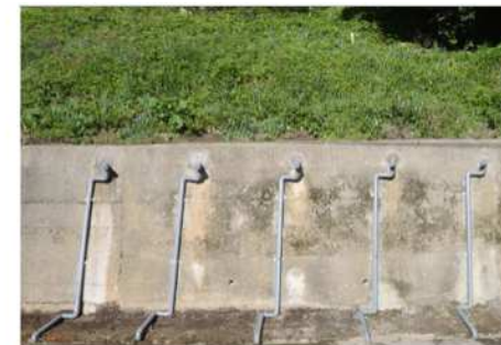
地下水排除工 (地下水を排除する水抜きボーリング)
