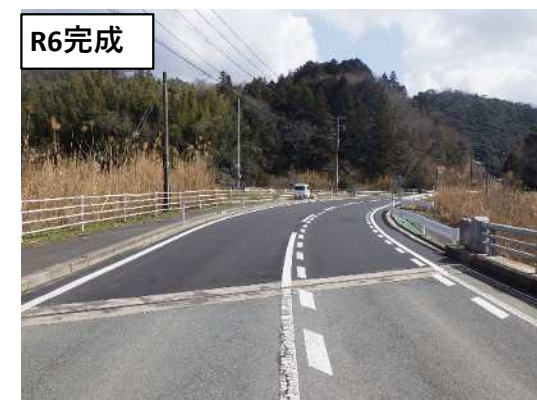
(主) 三瓶山公園線 (野城工区)
