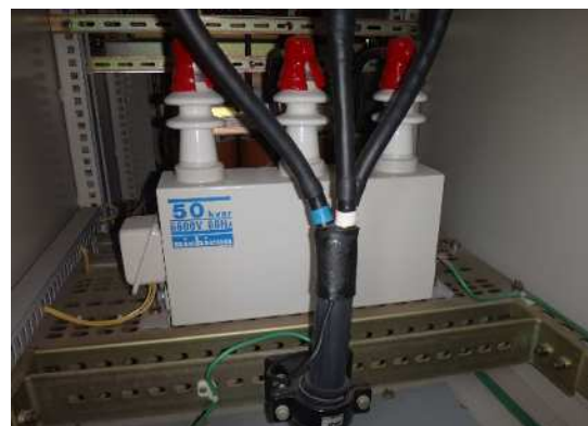
管理用発電設備 コンデンサ更新
