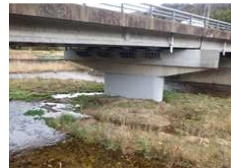
令和4年度完了 橋脚部
