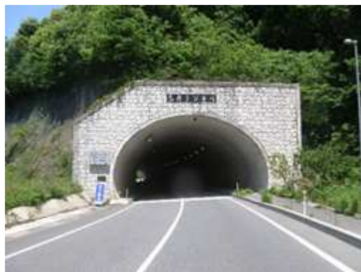
国道375号 忍原トンネル (R2年度完了)
