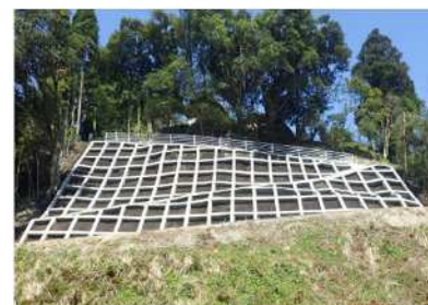
排土 + 法枠 (土砂を除去し斜面の安定を図る)
