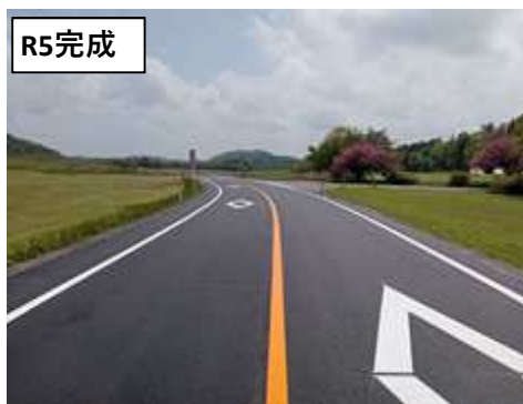
（主）三瓶山公園線（志学工区）
