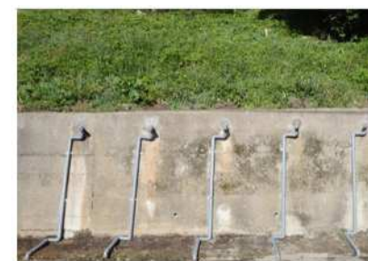
地下水排除工 (地下水の排除：水抜きボーリング)
