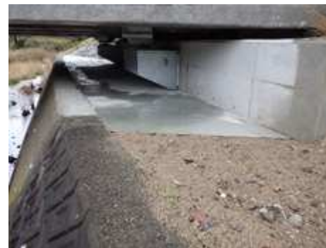
令和4年度完了 橋台部
