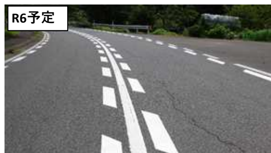
（主）三瓶山公園線（野城工区）
