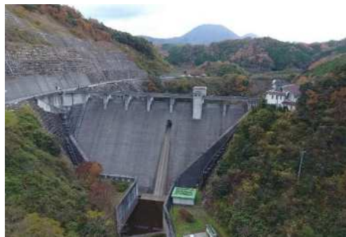
三瓶ダム本体全景
