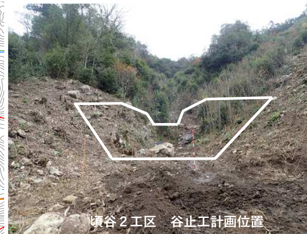
R6 填谷 2工区 谷止工
