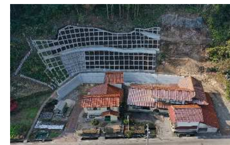
R5工事完了
