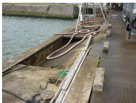
写真－１２ 上部工の陥没
