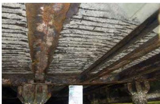
写真－１３ 上部工の劣化（下面側）
