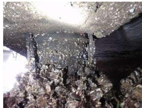
写真－１４ 杭頭部の腐食
