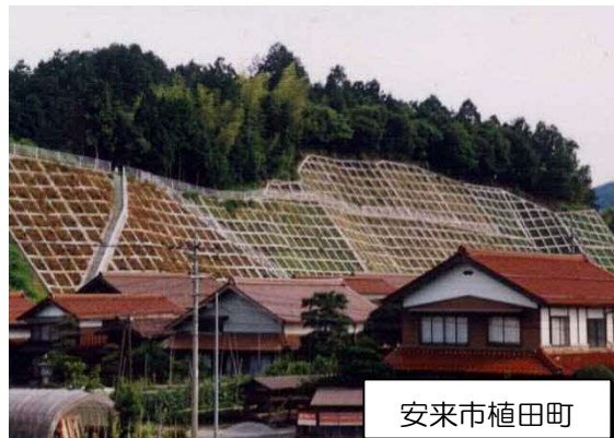
写真－４ 斜面对策工（法枠工）
