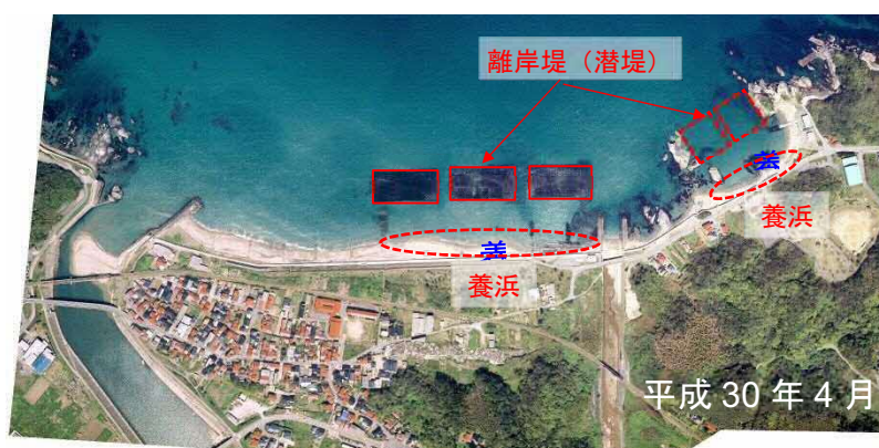
写真－10 (三隅港海岸) 侵食対策
