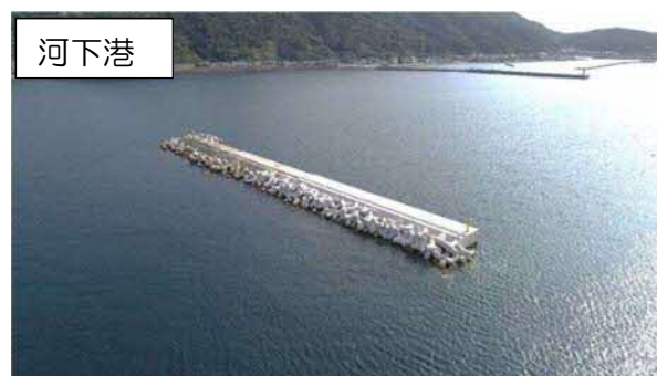
写真-6 沖防波堤の整備
