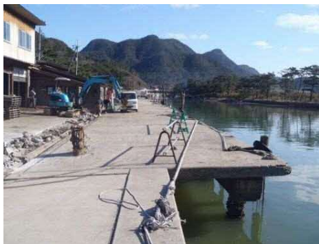
写真－１１ 健全な状態の栈橋
