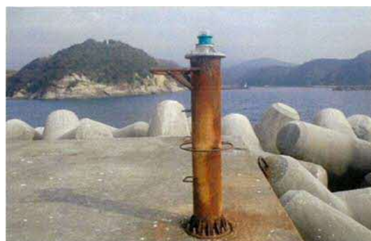
写真－１６ 小規模な施設修繕
