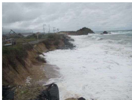
(侵食による被害状況)
