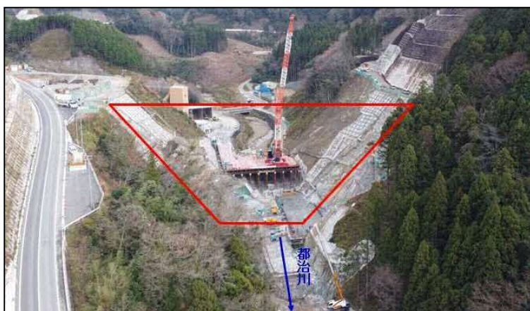
写真-7 本体コンクリート打設中の波積ダム
