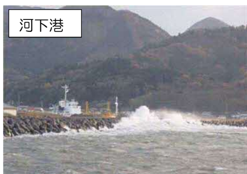
写真-5 海上が荒れた際の岸壁状況
