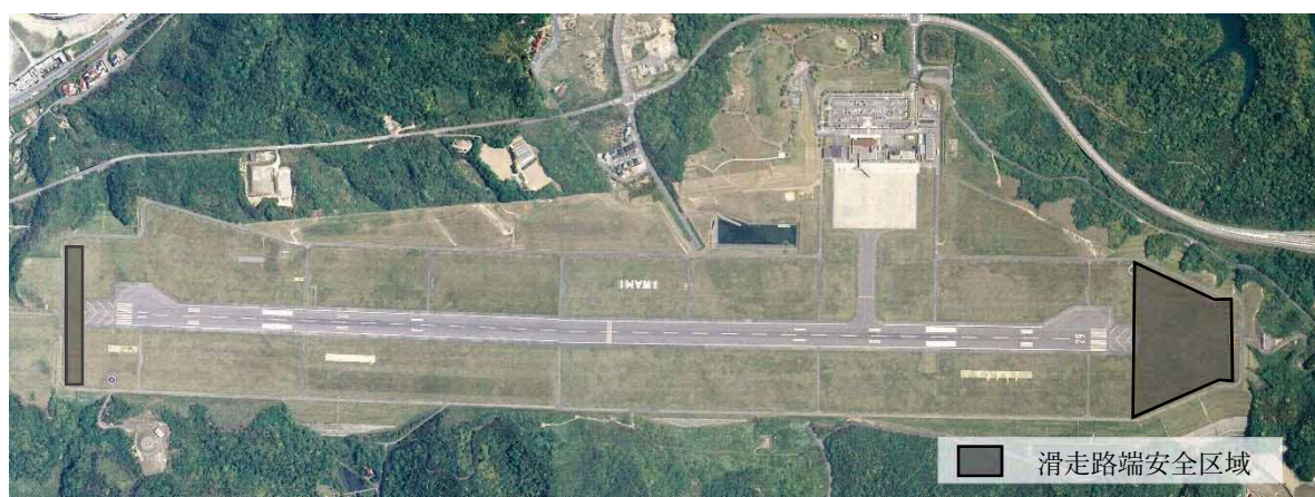
写真-6 現在の滑走路端安全区域（萩・石見空港）
