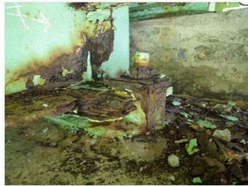
令和元年点検
