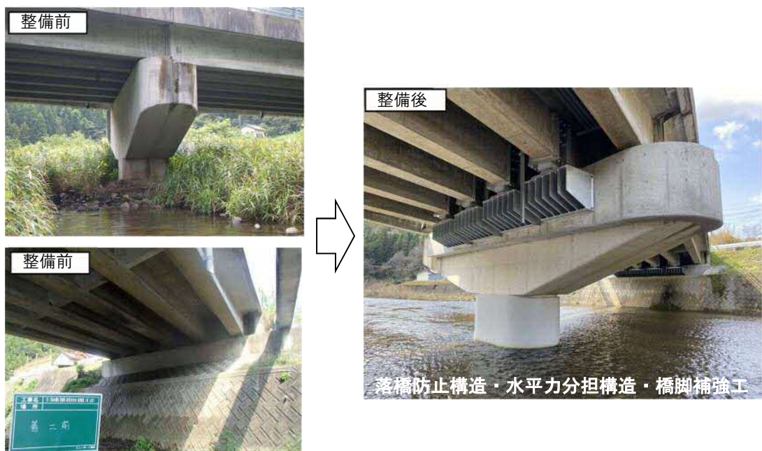
槇原橋 (主) 三瓶山公園線 (大田市大田町)
