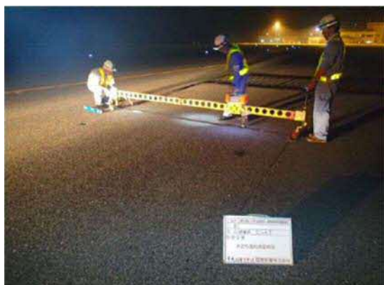
写真-4 滑走路定期点検状況
