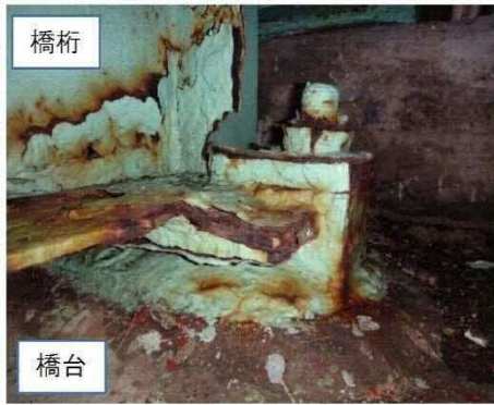
〔支承〕 平成 26 年点検
