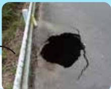
舗装の 陥没
