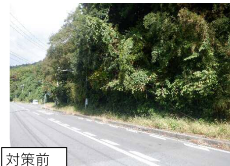
(主) 三瓶山公園線 (大田工区)
