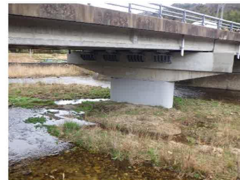
令和4年度完了 橋脚部
