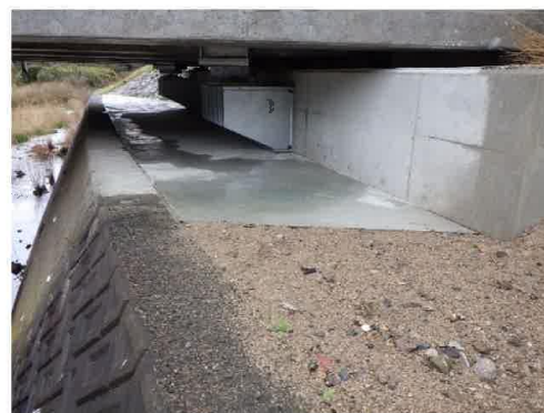
令和4年度完了 橋台部
