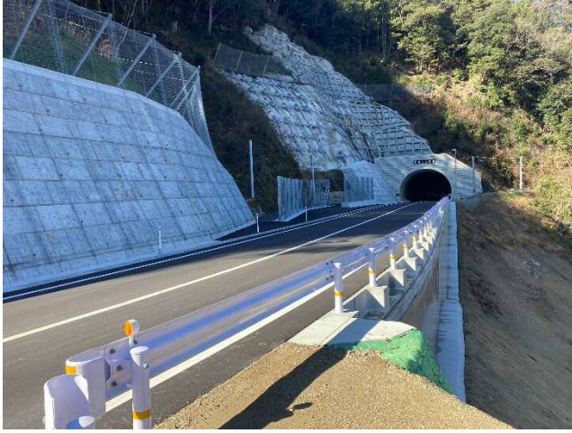
トンネル坑門付近の状況
