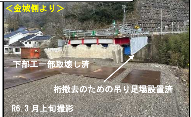
市山橋撤去工事の状況
