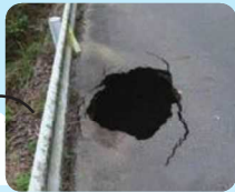
舗装の 陥没
