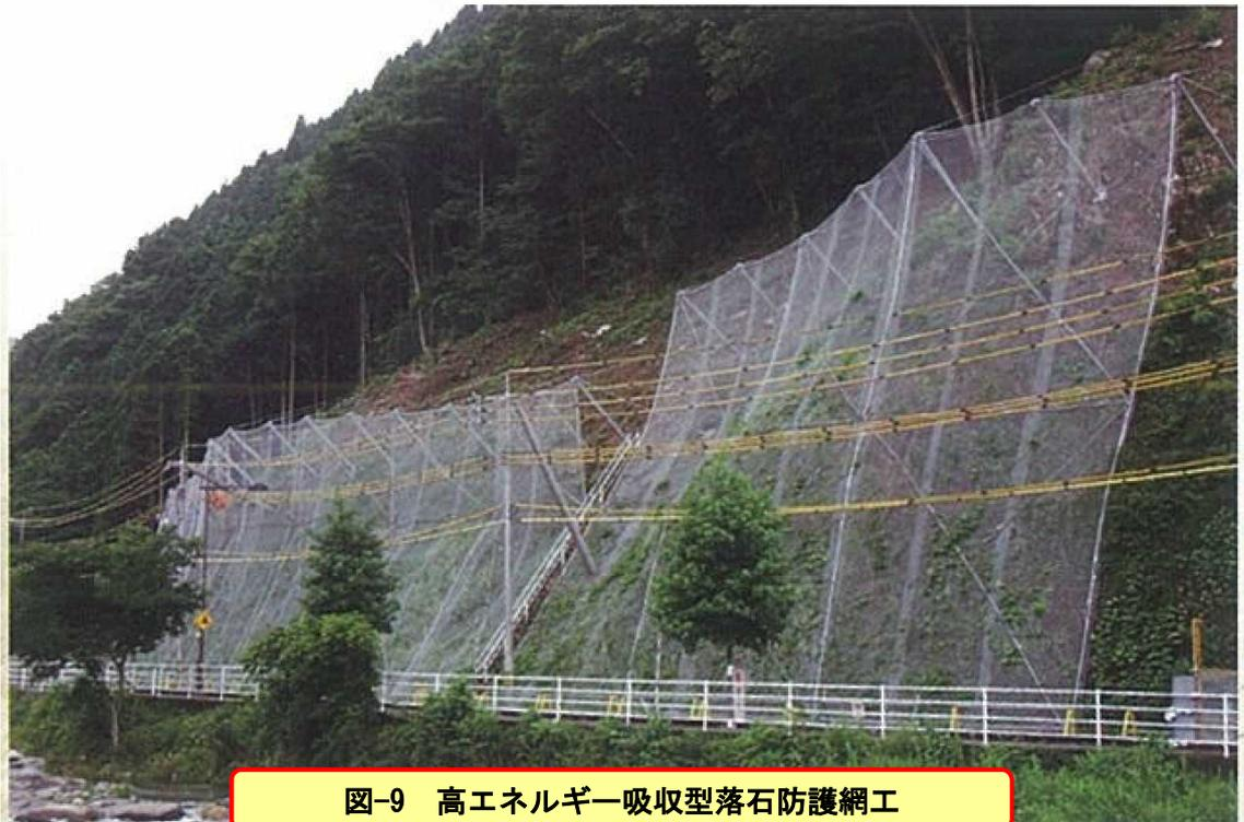
図-9 高エネルギー吸収型落石防護網工
