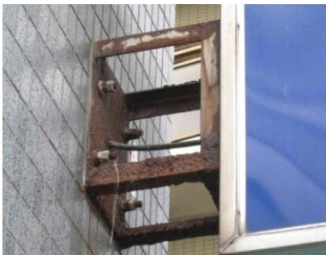
ブラケットの腐食による落下の危険のある看板
