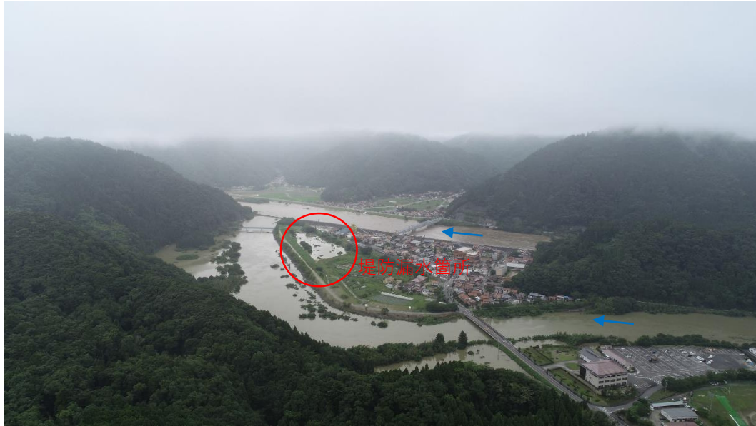
【八戸川：堤防漏水】
