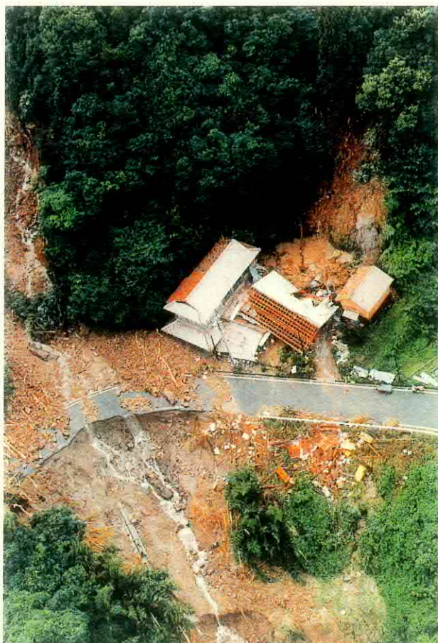
土砂により破損した道路と家屋（浜田市）
