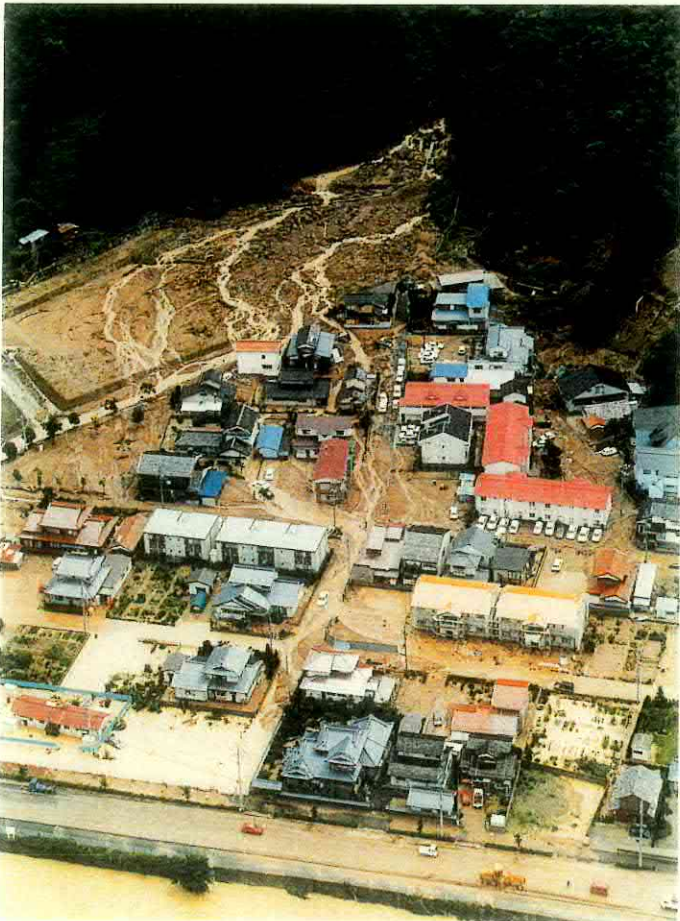
土石流に襲われた相生町（浜田市）
