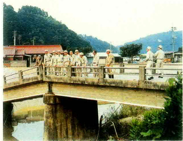
災害で壊れた橋の上に立つ衆議院の視察団（浜田市）
