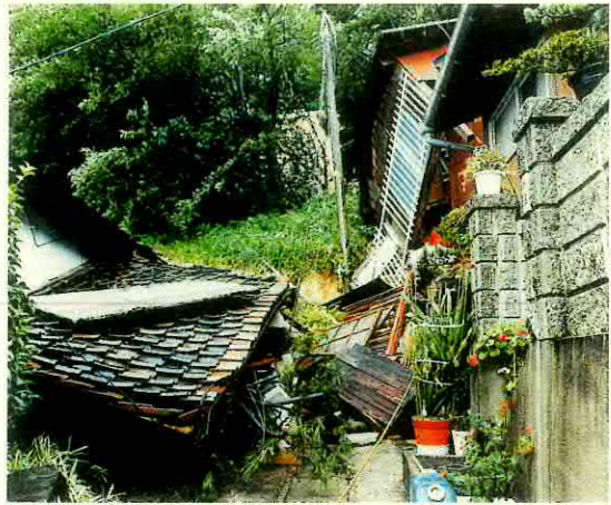
裏山の崩壊により全壊した家屋（浜田市）
