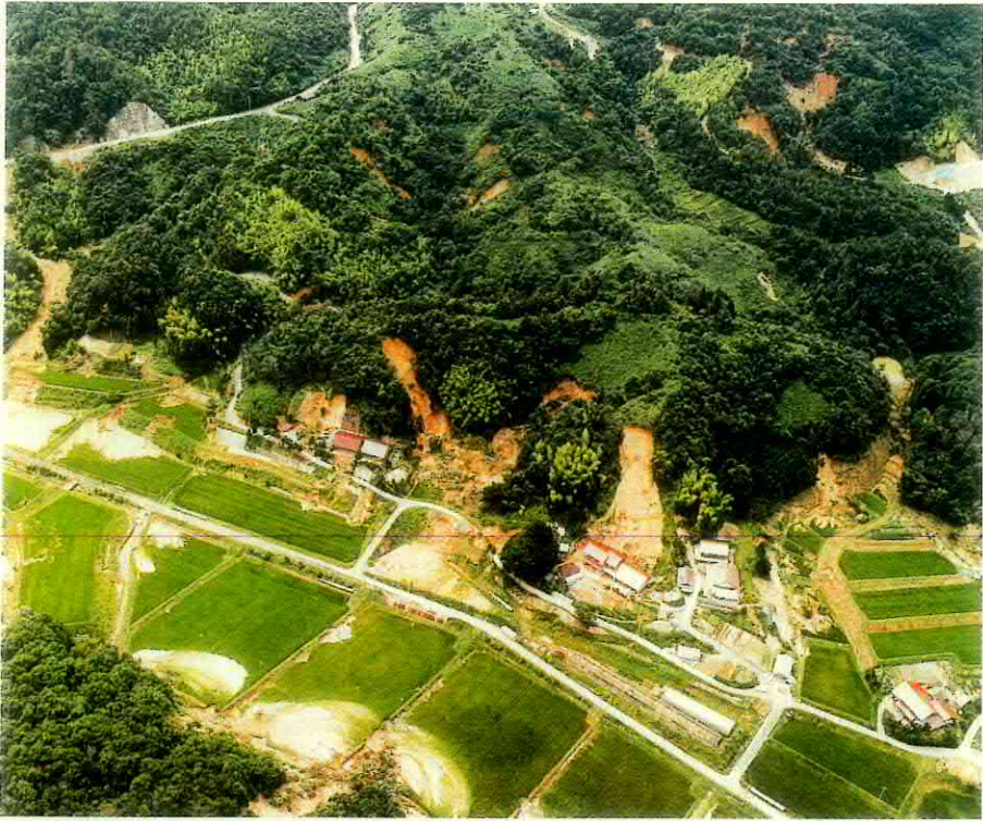
各所で山腹崩壊が発生
