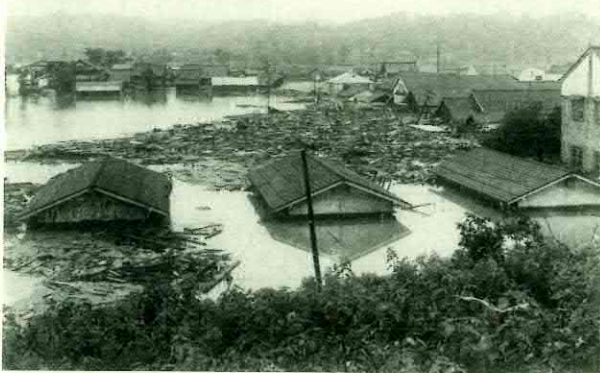
赤川の堤防決壊で水没した加茂町（大原郡加茂町）
