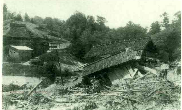
山崩れに襲われた家屋（大原郡加茂町）
