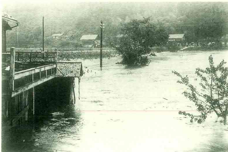
水没した連坦地（仁多郡横田町）
