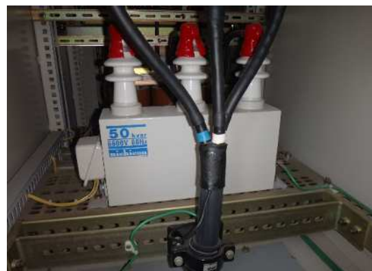
管理用発電設備 コンデンサ更新
