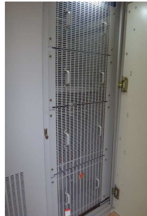
管理用発電設備 コンデンサ更新
