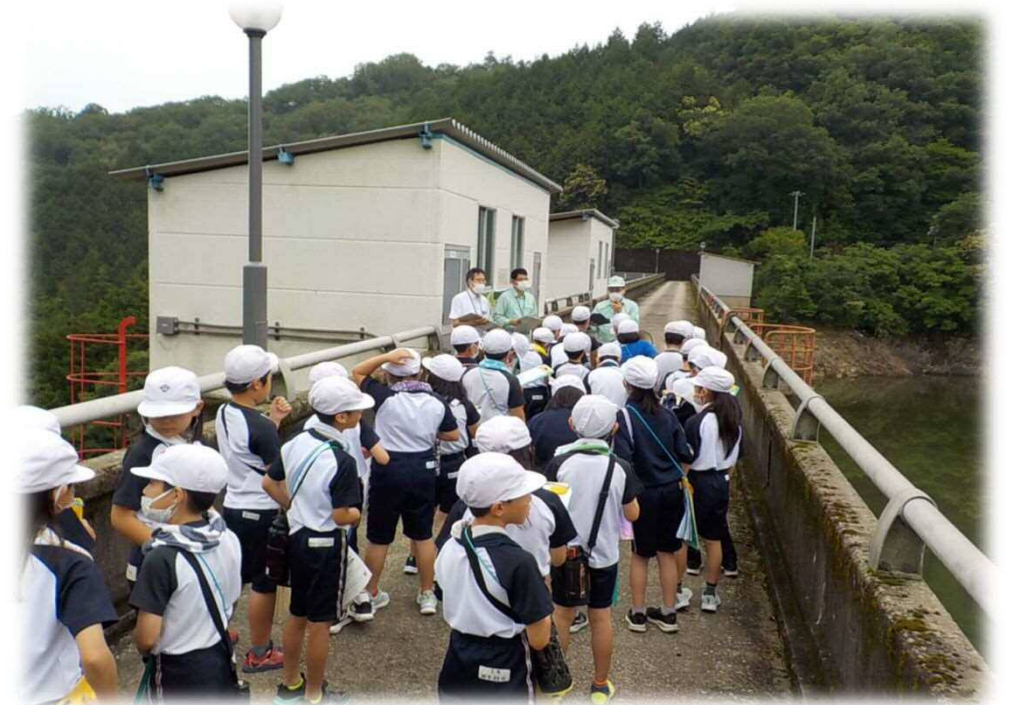
ダムの上を歩き、ダムの大きさを肌で感じる。
