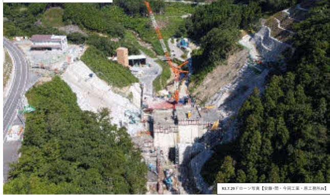
R3.7.29ドローン写真【夜間・今岡工業・原工務所AV】
