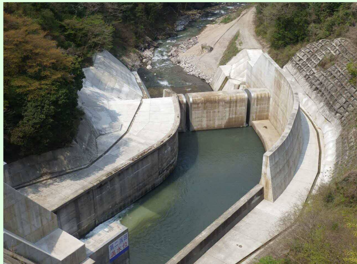
減勢工・工事用道路
