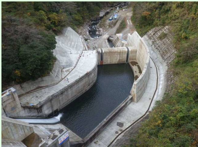
減勢工・工事用道路
