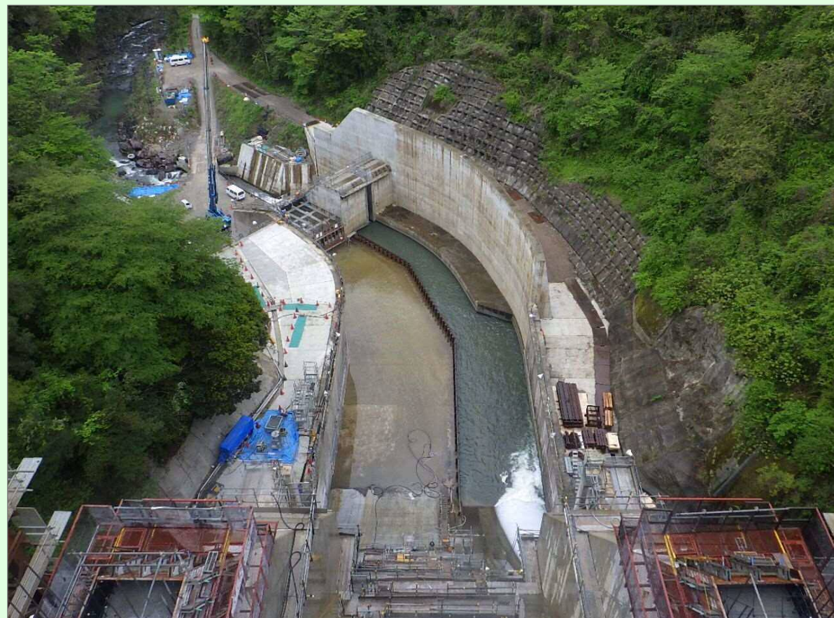
減勢工・工事用道路
