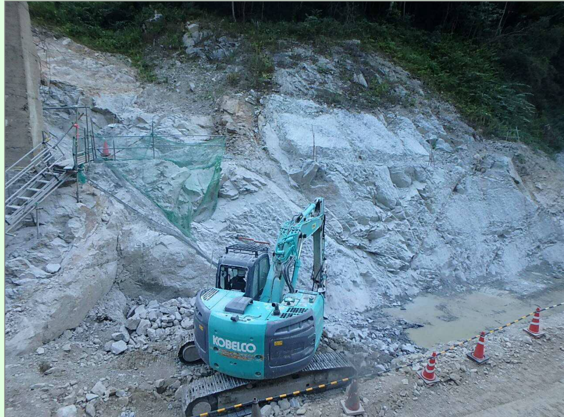
減勢工施工状況
