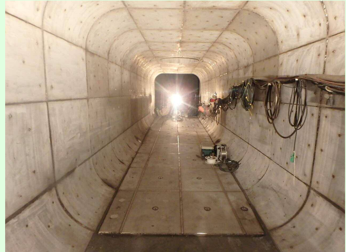
放流管ライニング施工状況
