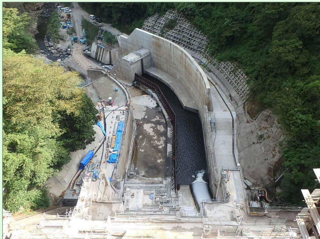
減勢工・工事用道路
