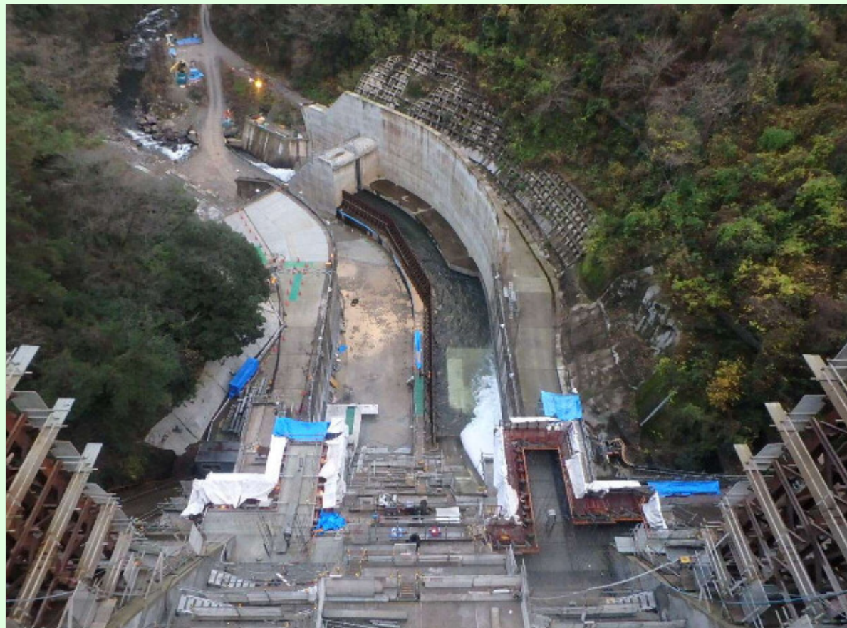
減勢工・工事用道路
