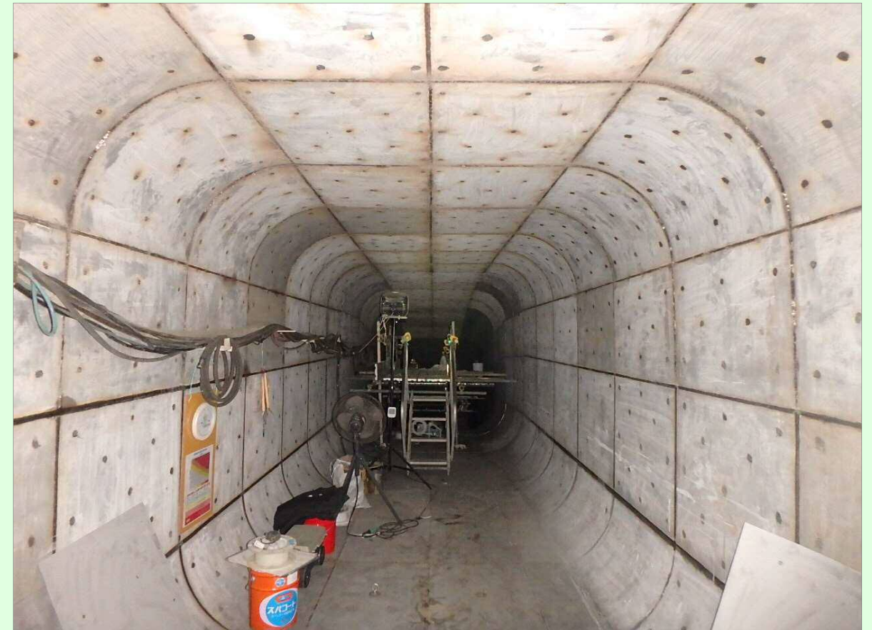
放流管ライニング施工状況
