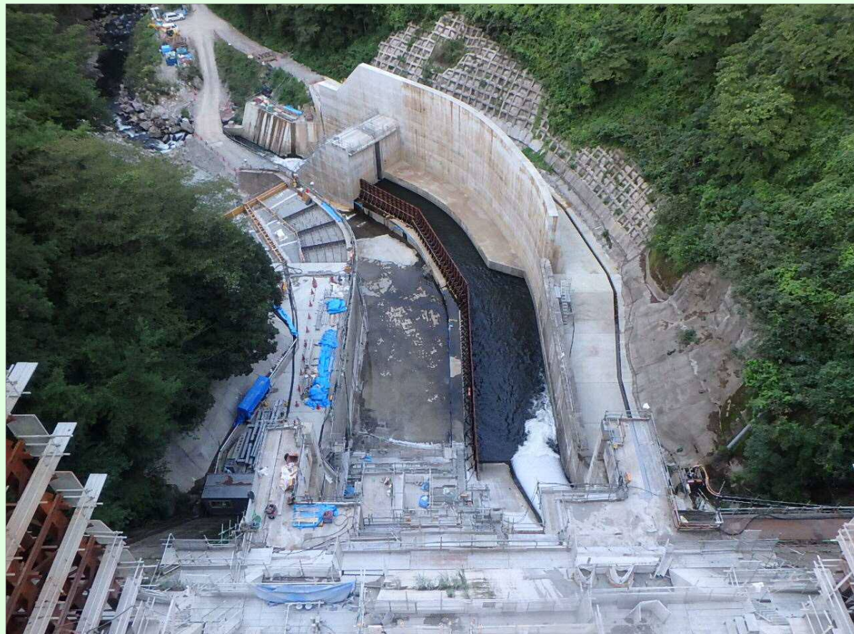
減勢工・工事用道路
