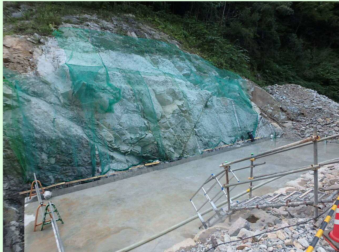
減勢工施工状況
